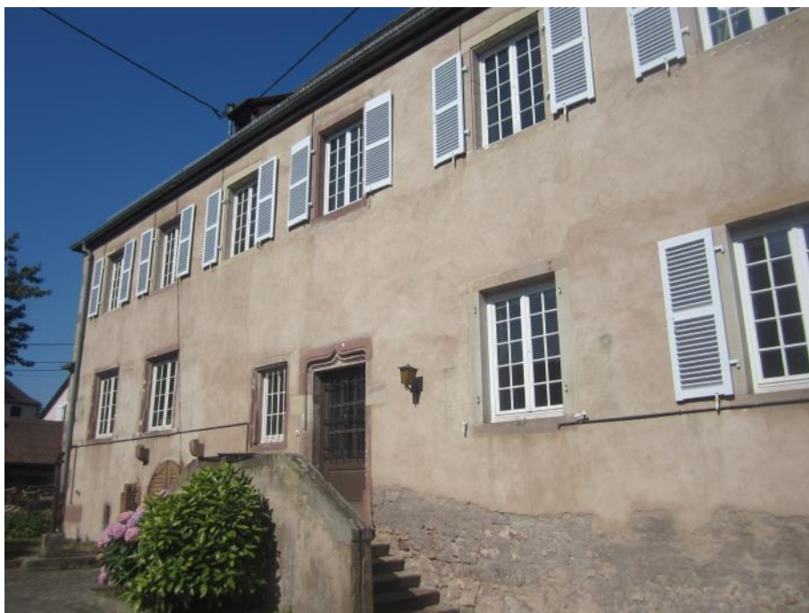
La Mairie, vue de la cour intérieure
