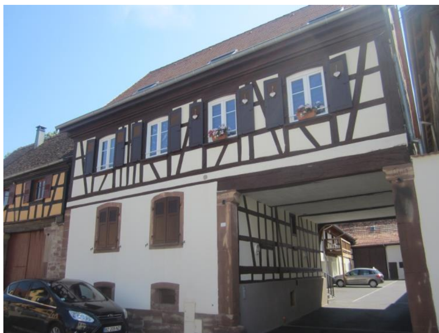
Exemple d'une réhabilitation réussie avec prise en compte du stationnement dans la cour
