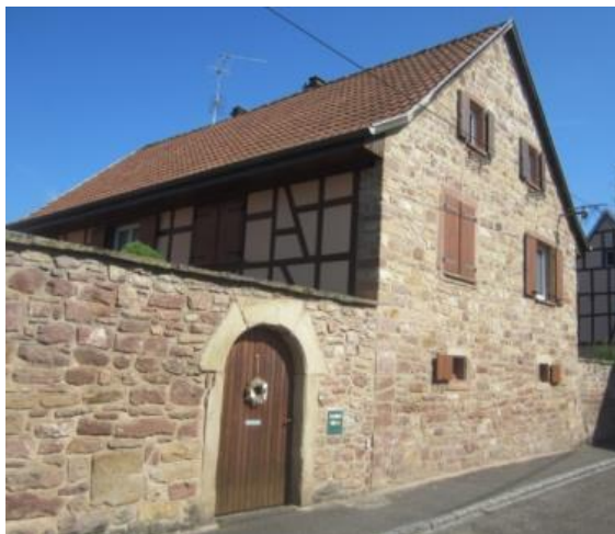
Exemple de rénovation en pierres
