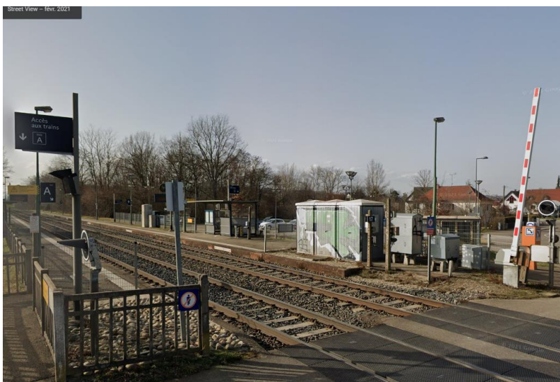
Gare de Dachstein (Source : Google Maps)
