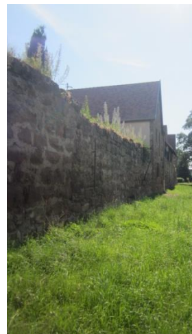
Exemple des remparts servant de murs porteurs
