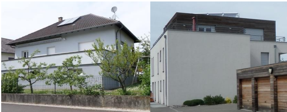
Exemples d'installations de panneaux solaires thermiques
