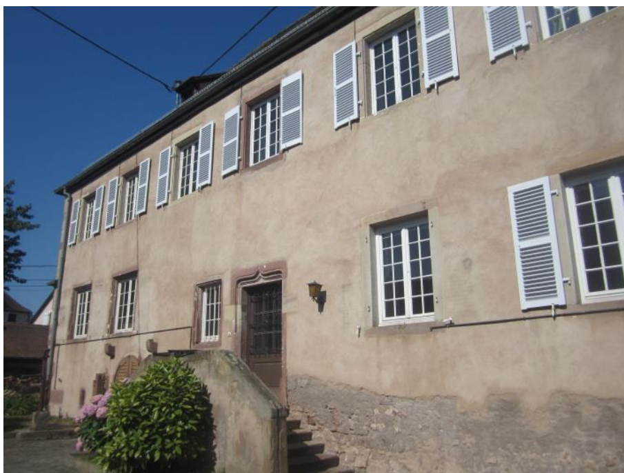
La Mairie, vue de la cour intérieure
