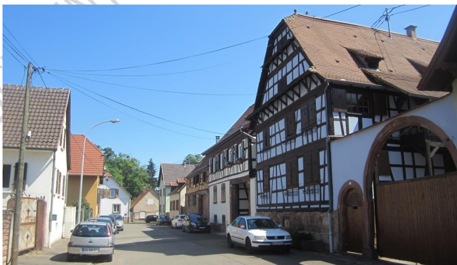
Implantation du bâti sur la limite d'emprise publique, rue du Couvent
